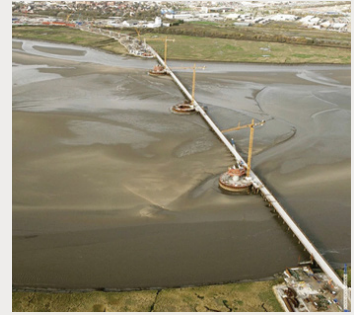
Construcción de los cofferdam del puente de Mersey. Fernando Flores. Cofferdam construction in the Mersey Bridge.UK
