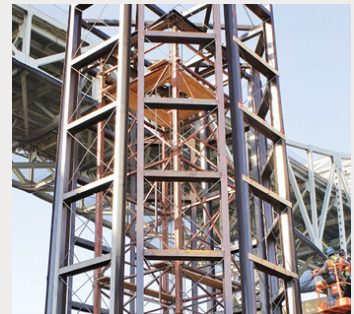
Torre principal del Puente Gerald Desmond. Julio G.Ruiz.
